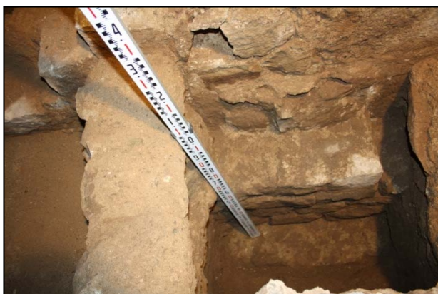
Fotografia 47. Detall fonamentació estructura UE180 en àmbit sud
