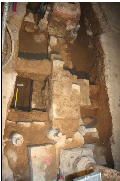
Fotografia 35. Vista general encepats 6 i 7
