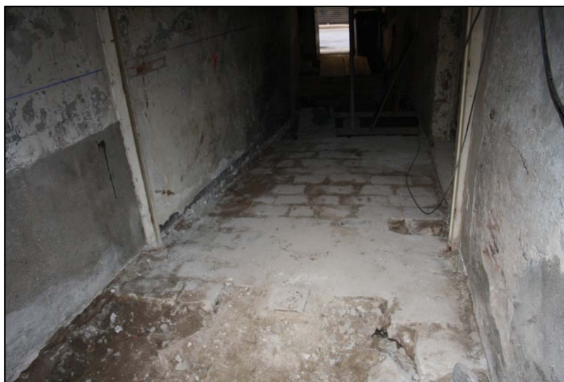
Fotografia 99. Paviment del passatge fet amb llambordes UE135
