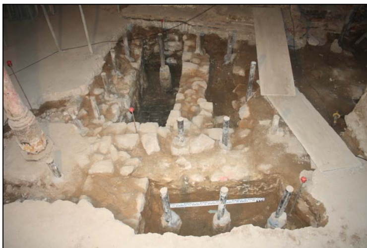
Fotografia 66. Vista general àmbit d'actuació
