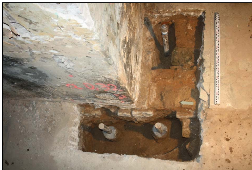
Fotografia 88. Mur UE255 amb claveguera UE263
