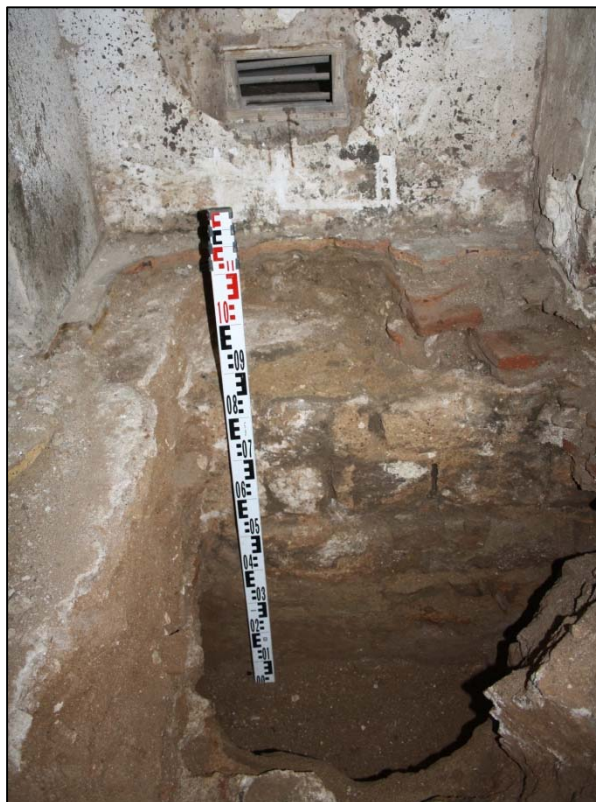
Fotografia 12. Fonamentació mur façana Mirallers 12
