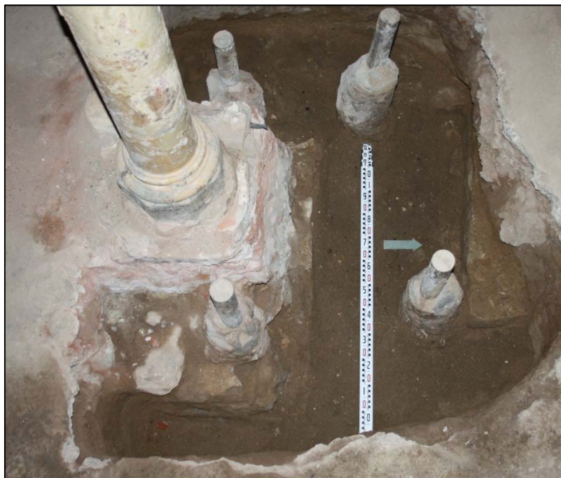
Fotografia 49. Vista de les estructures segles XVI UE171 i UE173
