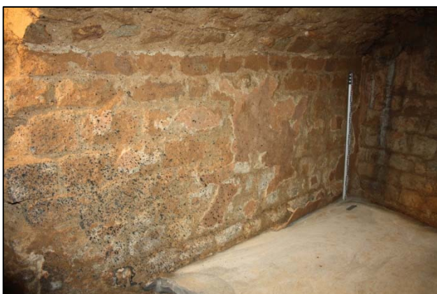
Fotografia 21. Vista mur occidental cisterna amb restes d'enlluït interior
