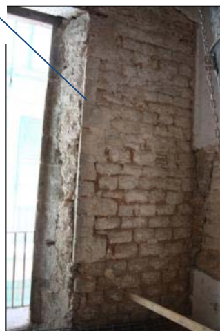
Mur de façana de la finca Mirallers 12 (UE311) documentat en la primera planta de l'actual finca
