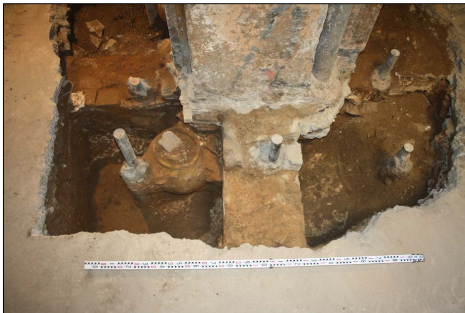
Fotografia 55. Vista general estructures finca baix medieval
