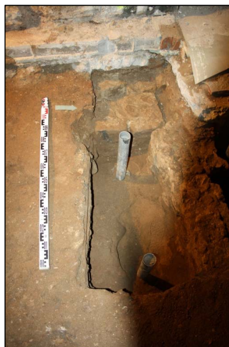
Fotografia 25. Estructura UE106 amb estrats UE129 i UE41
