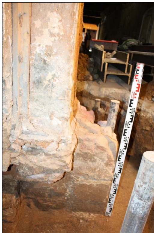
Fotografia 61. Estructura UE199 un cop desmuntat el mur UE162
