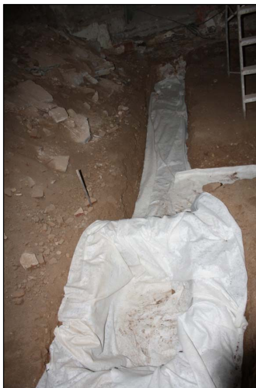
Fotografia 11. Cobriment estructures documentades rasa sanejament Mirallers
